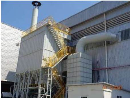
ภาพที่ 2.2-5 เครื่องดักฝุ่นชุดที่ 1,2 (Dust Collector) (ไซโคลนและเครื่องดักฝุ่นแบบถุงกรอง (Bag Filter))
