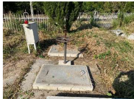
ภาพที่ 2.2-20 บ่อตรวจสอบคุณภาพน้ำ (Inspection Manhole)
